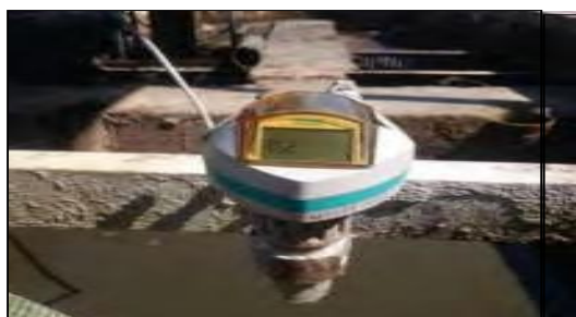
ETP inlet Effluent Flow meter
